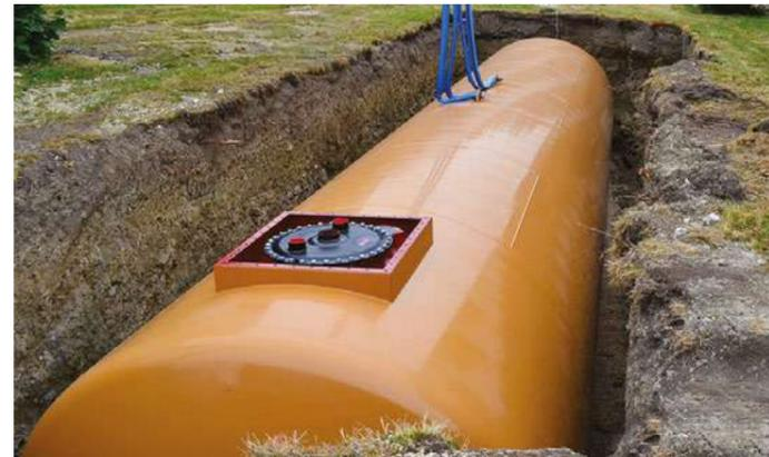
Cuves à enterrer pour récupération des eaux de pluie ou eaux usées. Cuves neuves avec revêtement extérieur polyuréthane 2500 volts. Contenance de 1500 à 120000L.
